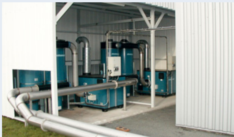
Fig. 23. Centrale d'aspiration.
