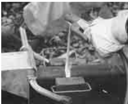
Soudage des rails en coffrage: OK 74.78
