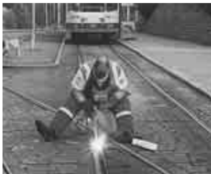
Réparation des rails de tramway: OK 67.52
