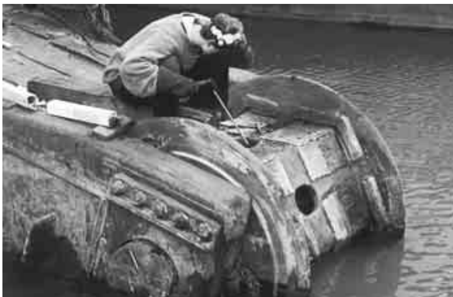
Rechargement dur d'un excavateur avec OK 84.84 - sous-couches avec OK 83.28
