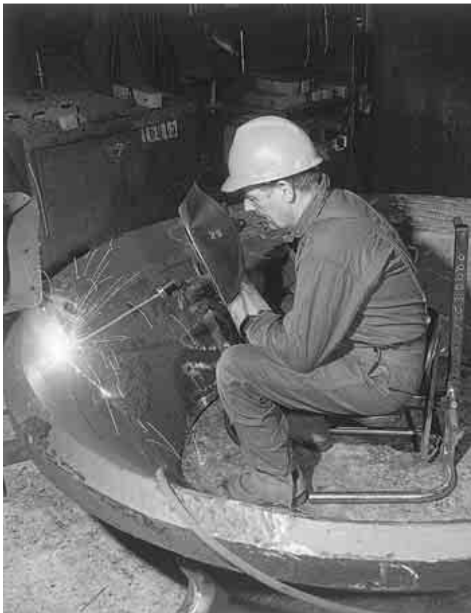
Réparation d'un broyeur en acier à 14% manganèse avec OK 86.08
