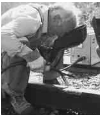
Réparation d'une empreinte de roue OK Tubrodur 15.43
