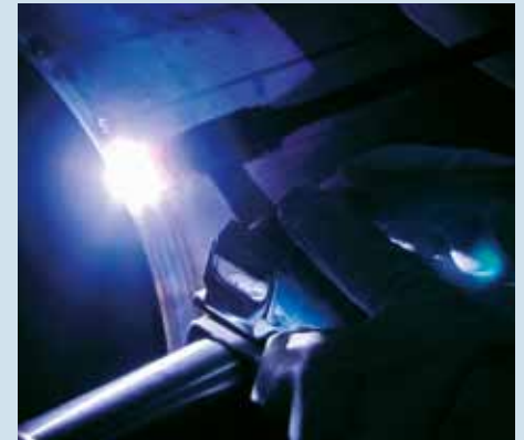
Soudage sous protection Formiergaz
