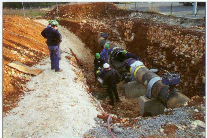
Figure 13 : Opération de désaimantation d'un pipe.
