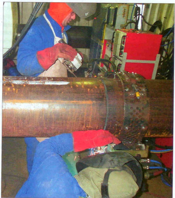
Figure 5 : Opération de soudure MIG semi-automatique.
